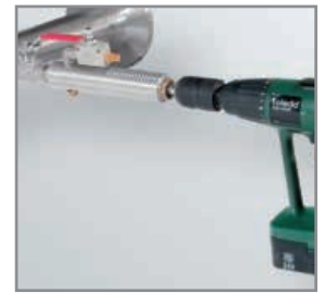
Anbohren unter Druck mit der CS Bohrvorrichtung
