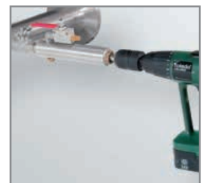
Anbohren unter Druck mit der CS Bohrvorrichtung
